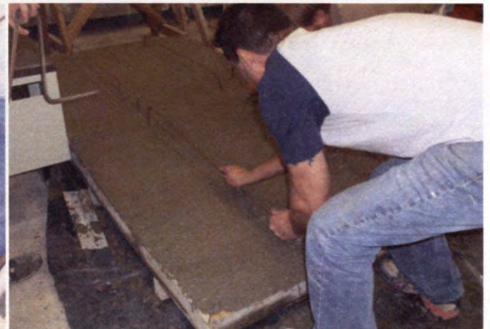
(d) Placing the Stirrups
