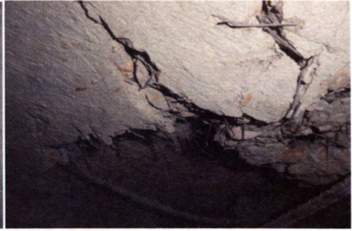
(d) Hole in the Tension Face
